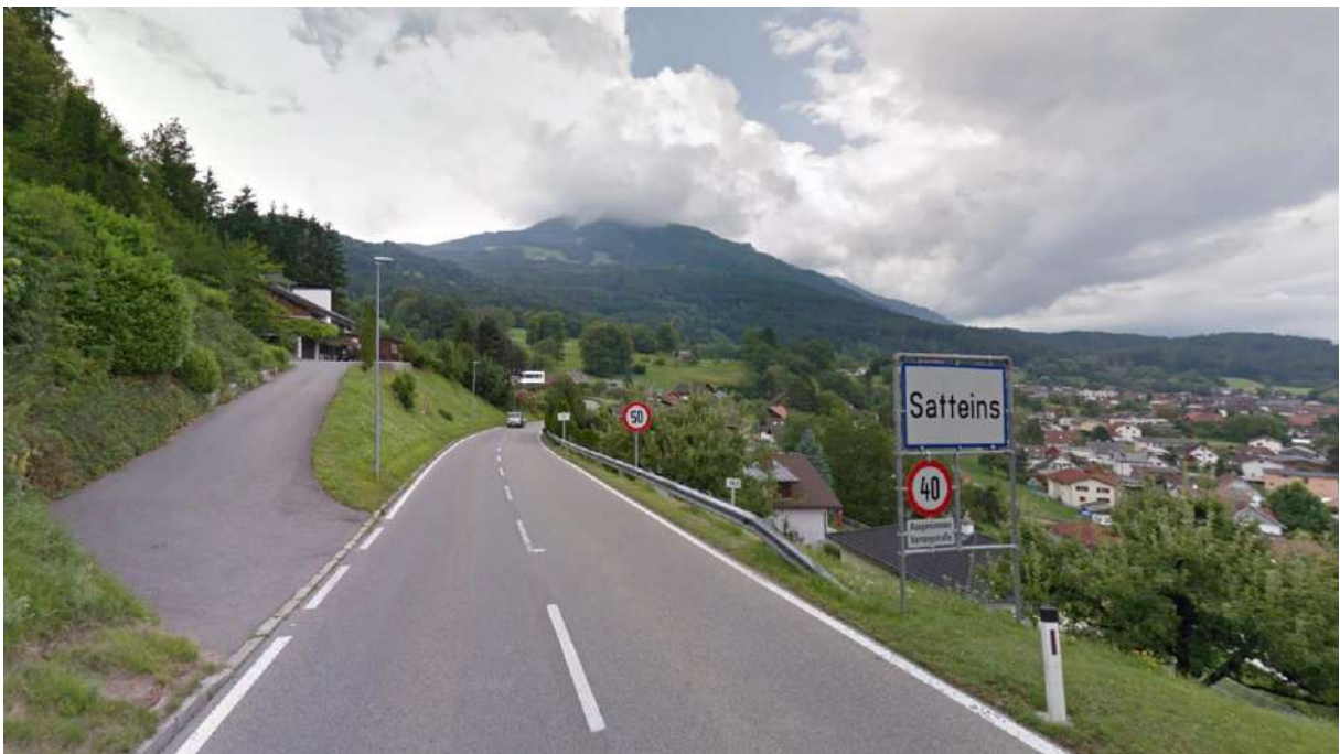
Abb. 3: Ortstafel L50 Rankweilerstraße (Quelle: Google Street View)
